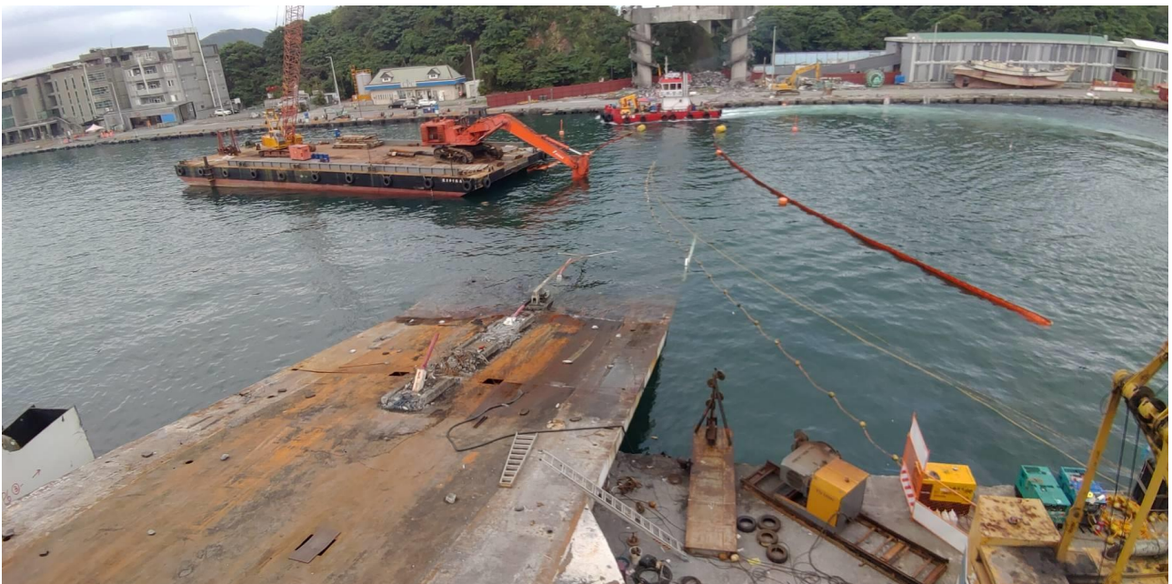
圖 1：南方澳跨海大橋橋面版拆除多工作面同步併行
