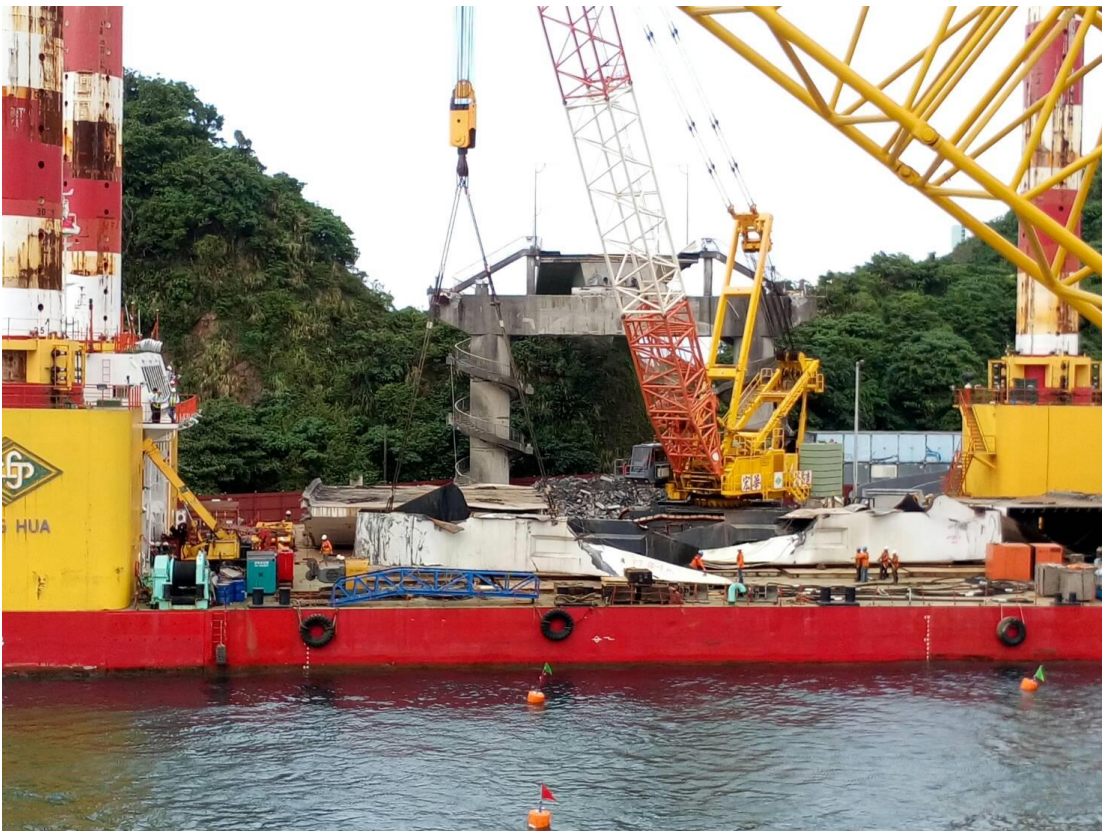
圖 1. 豆腐岬側橋面版及 Y 型鋼樑已吊離完畢
