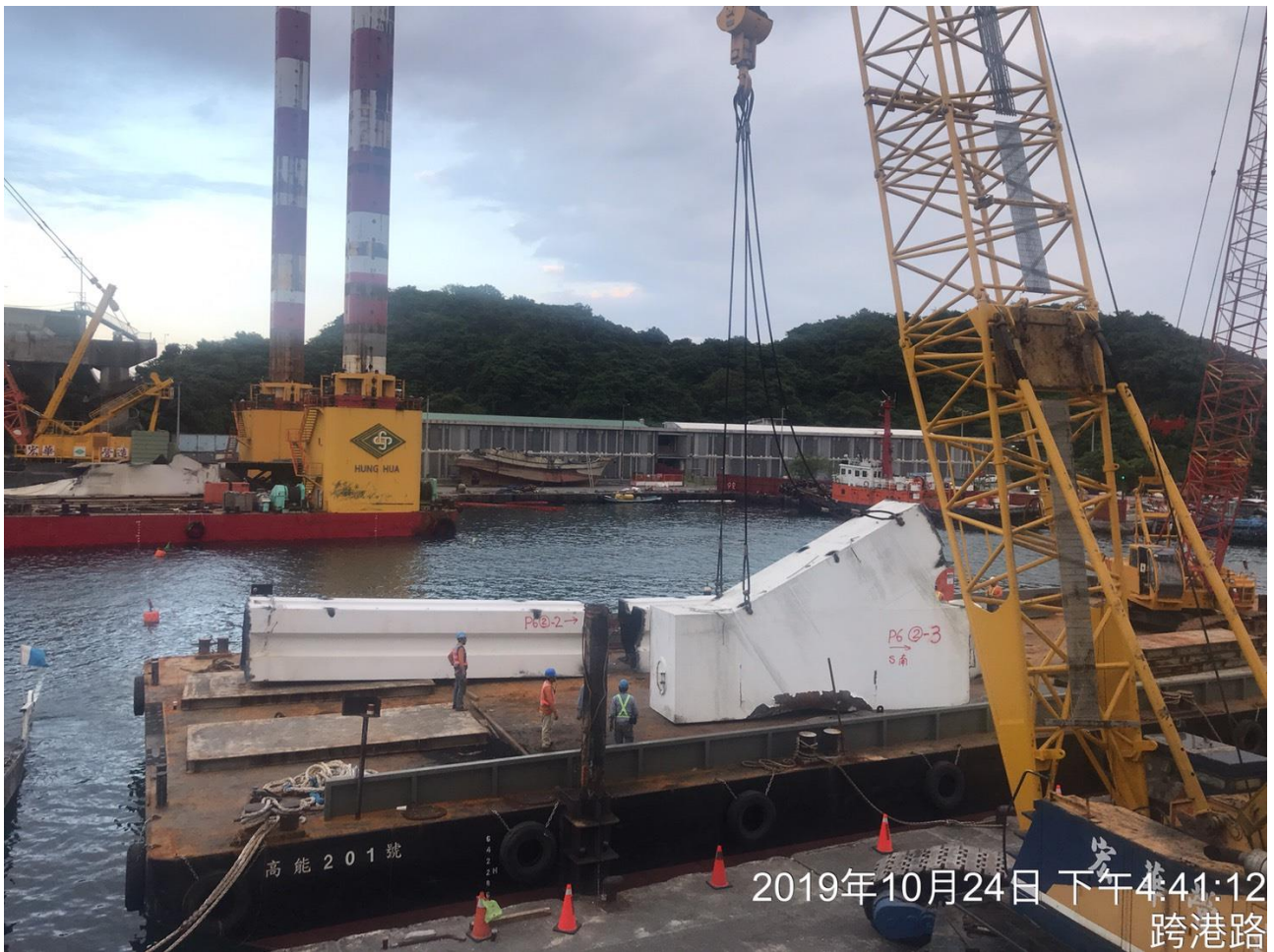
圖 2. 高能 201 號平台船同步進行移山路側 Y 型鋼樑吊離作業高能 201 平台船進場作業增加工作面積實況
