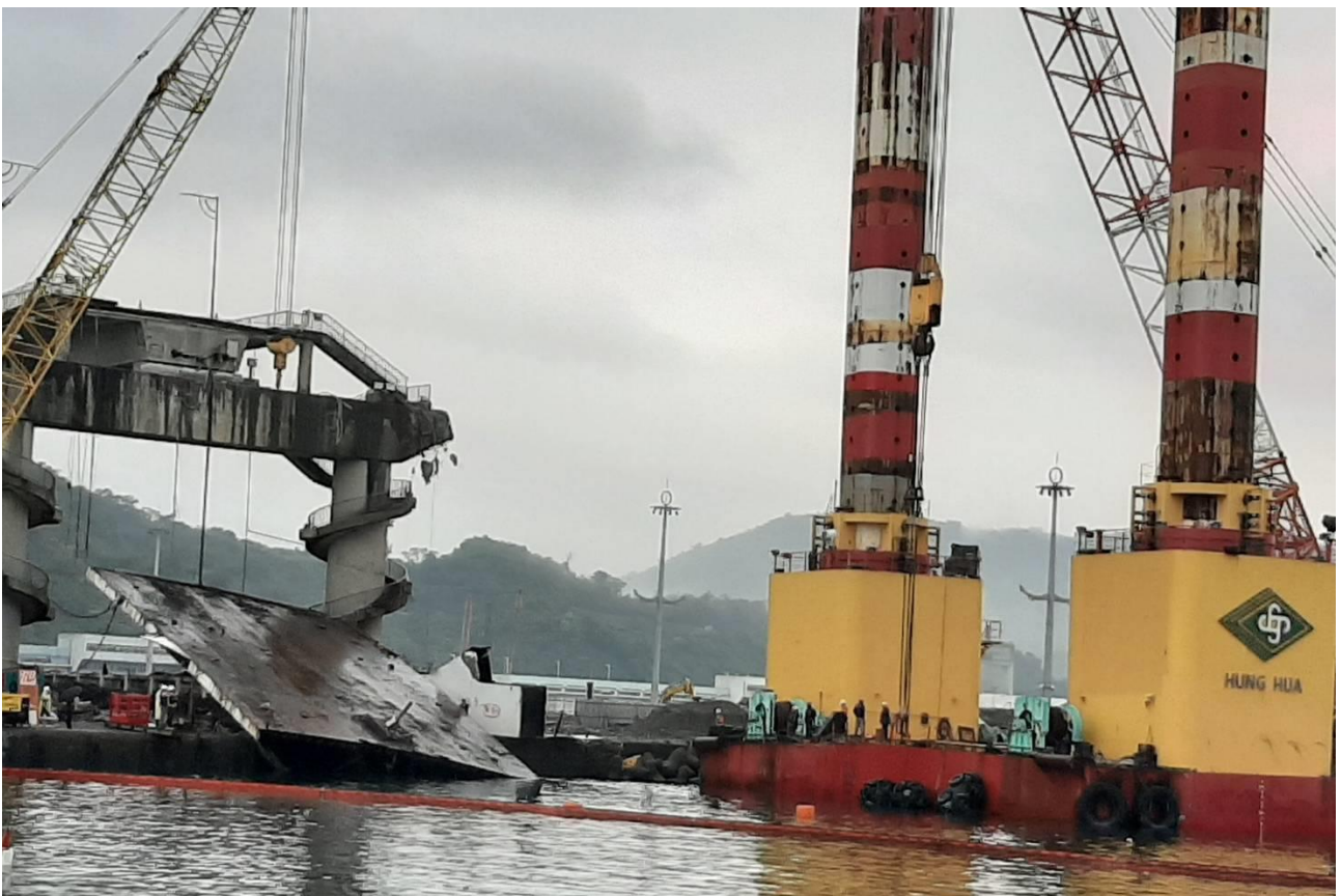
圖 1：宏禹 1 號今日移泊至移山路側碼頭準備吊離橋面版
