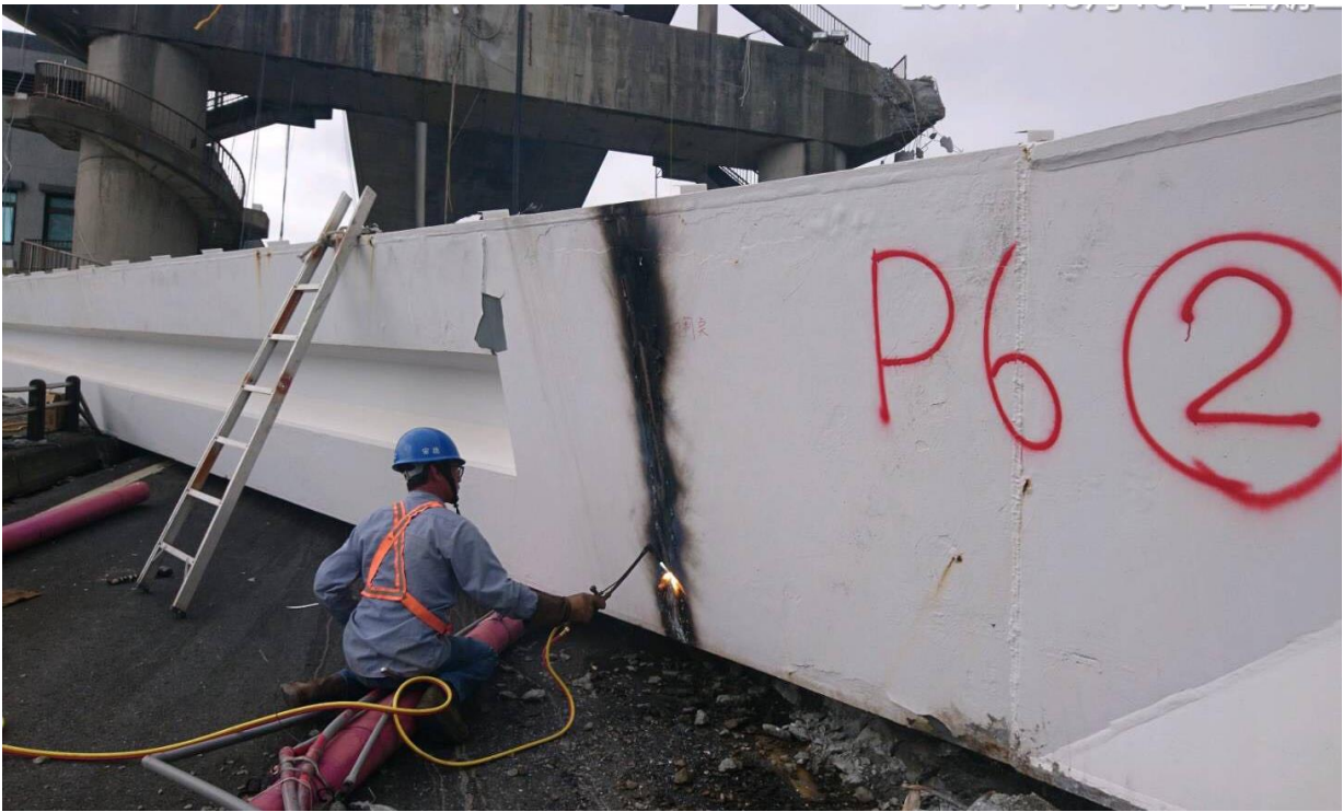
圖 2 移山路側 Y 型鋼樑切割情況
