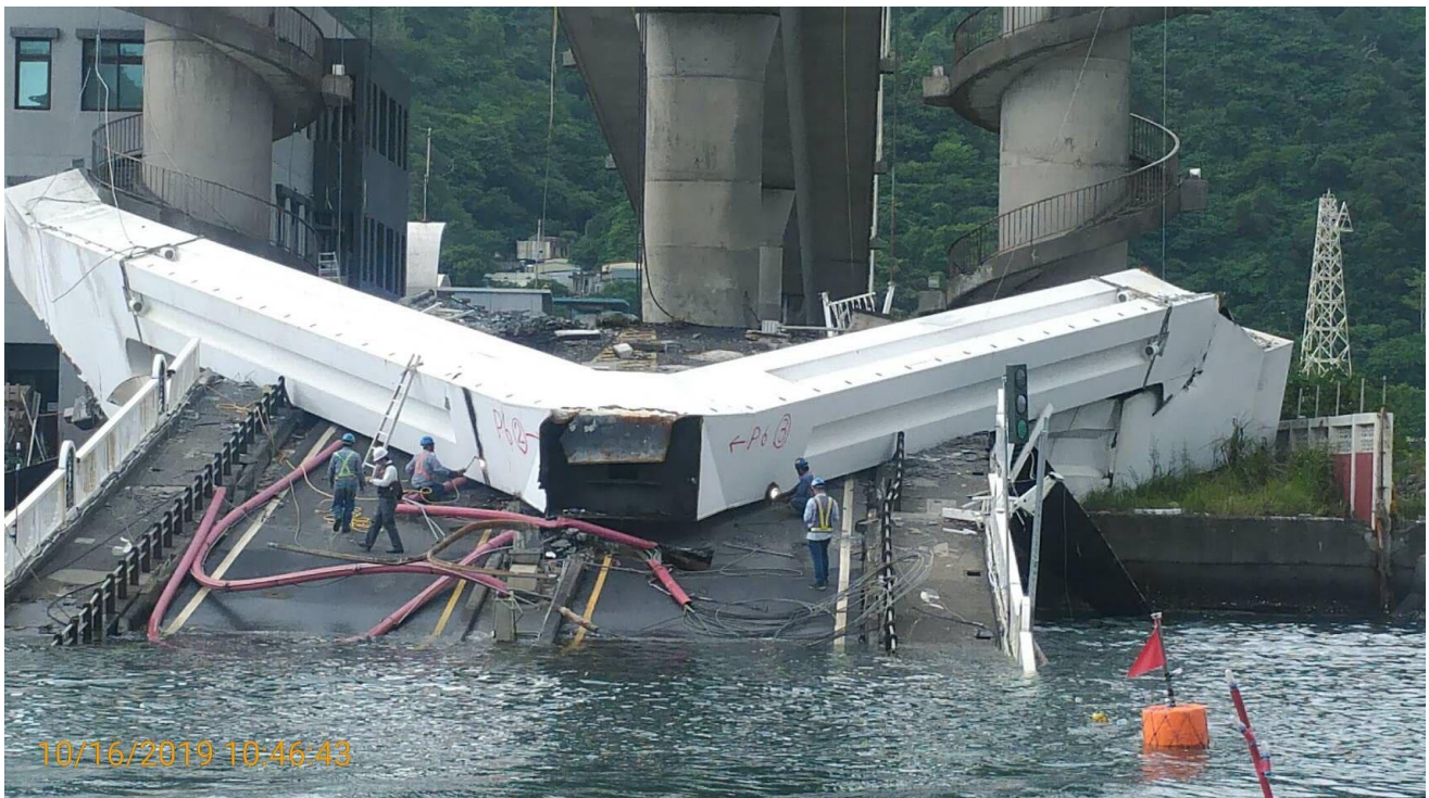
圖 1: 移山路側 Y 型鋼樑切割情況
