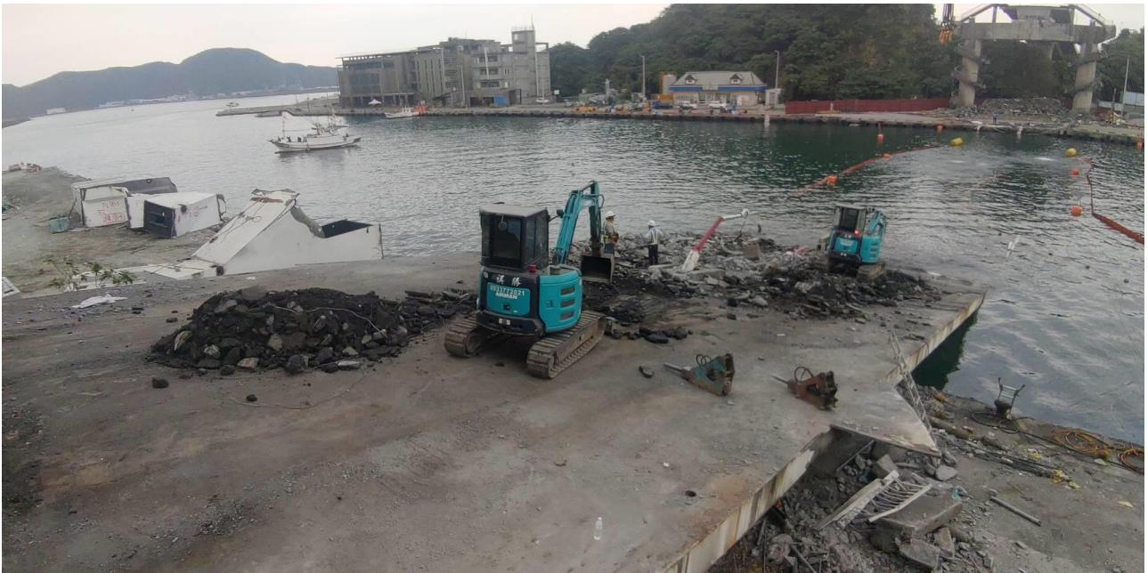
圖 1 跨海大橋移山路側之瀝青及混凝土打除完畢，準備進行切割
