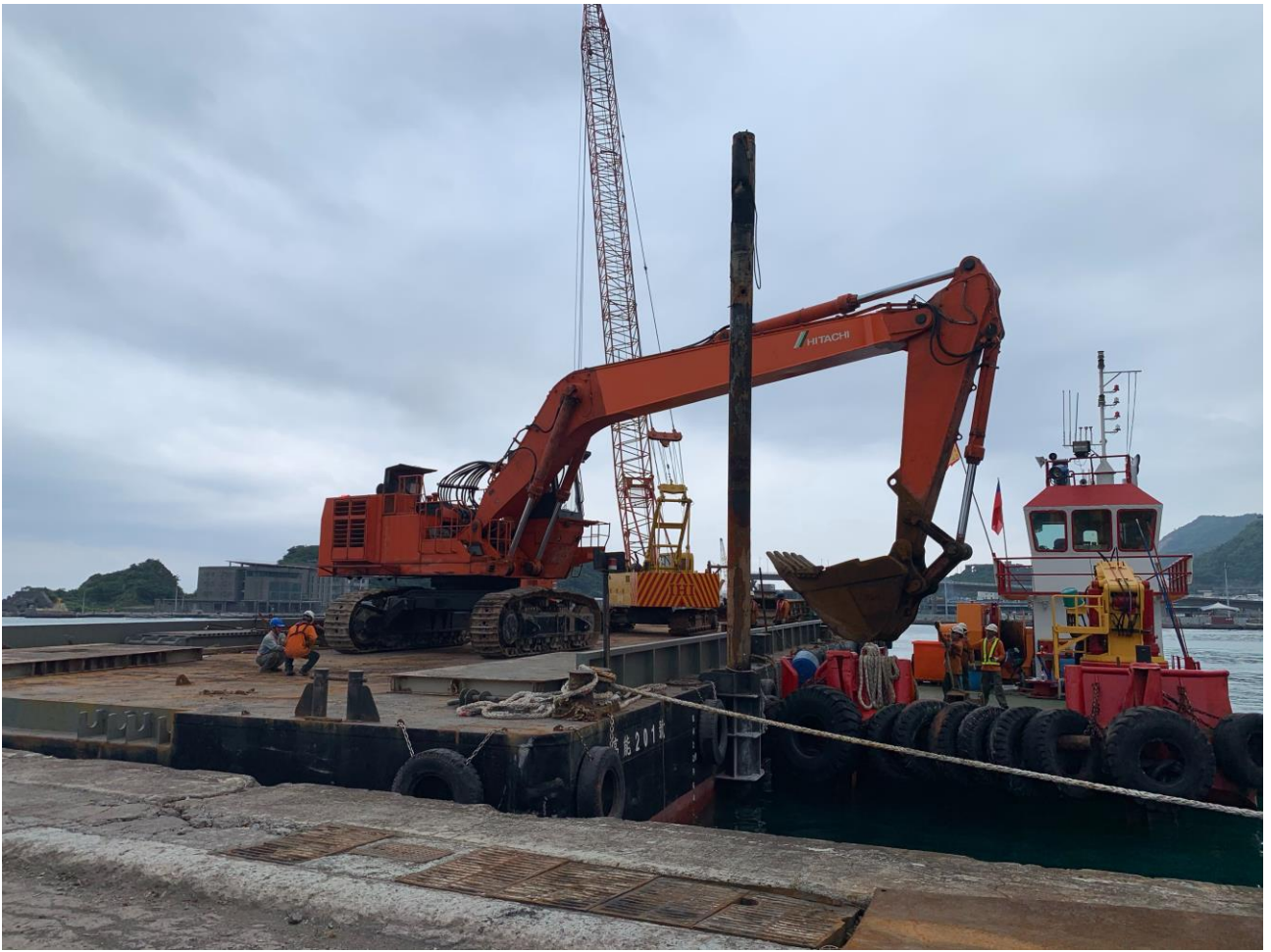
圖 2 高能 201 號平台船搭配近百噸大型長臂怪手投入清除作業
