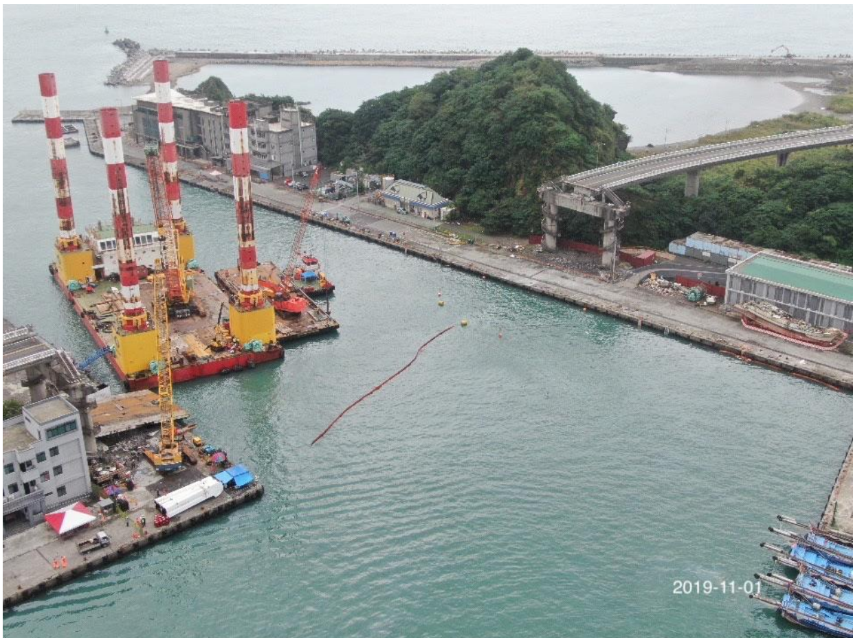
圖 1：宏禹 1 號已靠泊移山路碼頭，準備吊離陸側橋面版。
