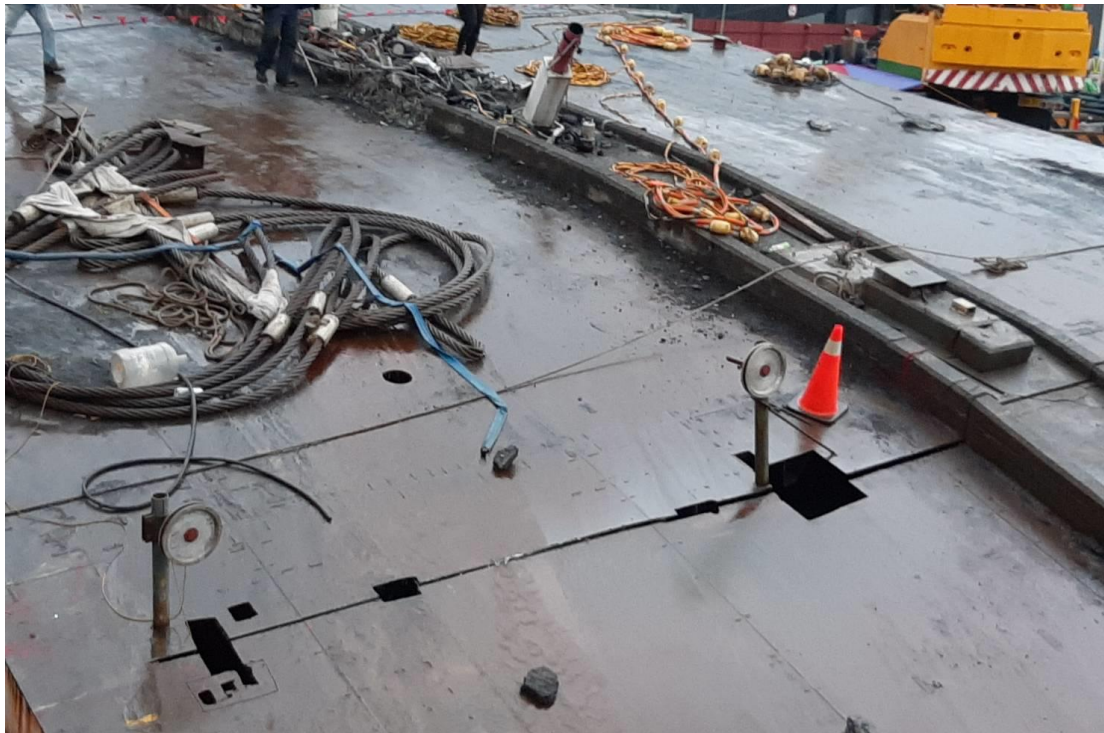
圖 1:下午 4 時間南方澳跨港大橋橋面版第二條切割線第三段切割完成
