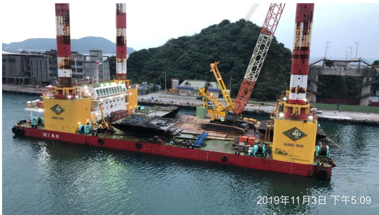
圖 1：宏禹 1 號今（3）日再吊離水下 3 塊橋面版
