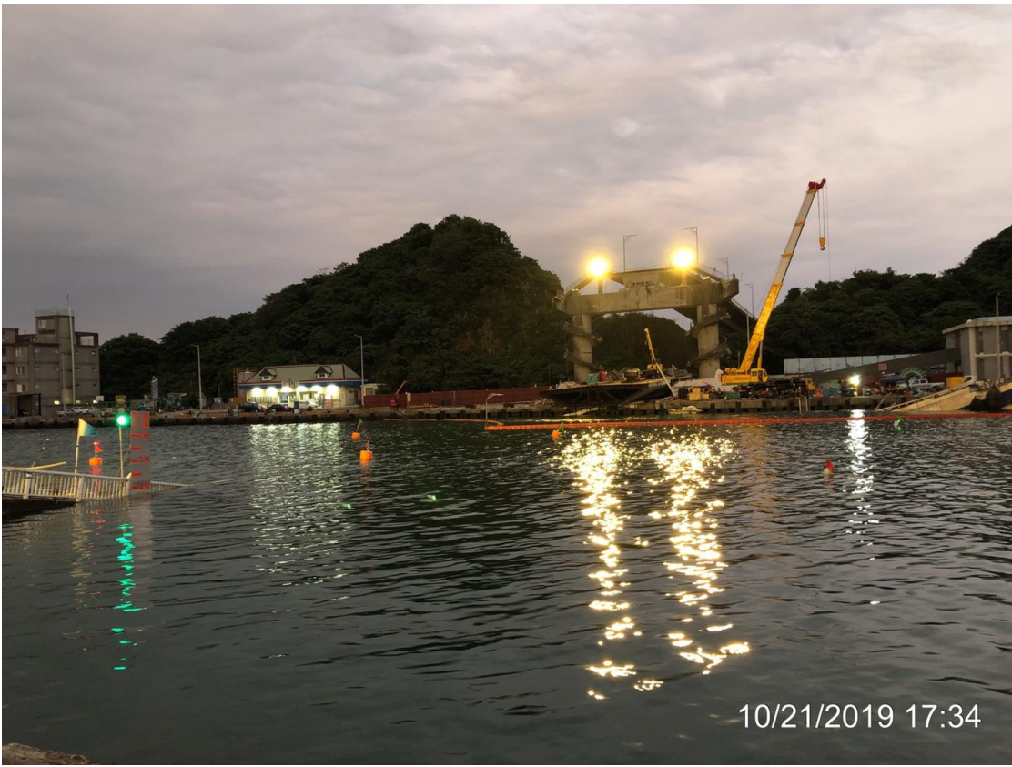
圖 2: 南方澳跨港大橋拆除作業進度及男興加油站碼頭提早恢復加油
