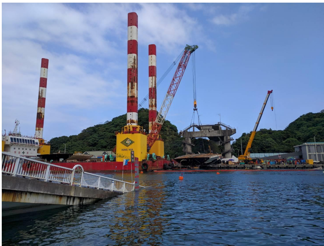
圖 1：南方澳跨港大橋第二塊橋面已於今日完成切割及吊離
