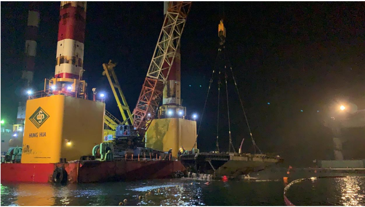
圖 2：今(4)日晚上 21：50 吊離第一塊橋面版之照片
