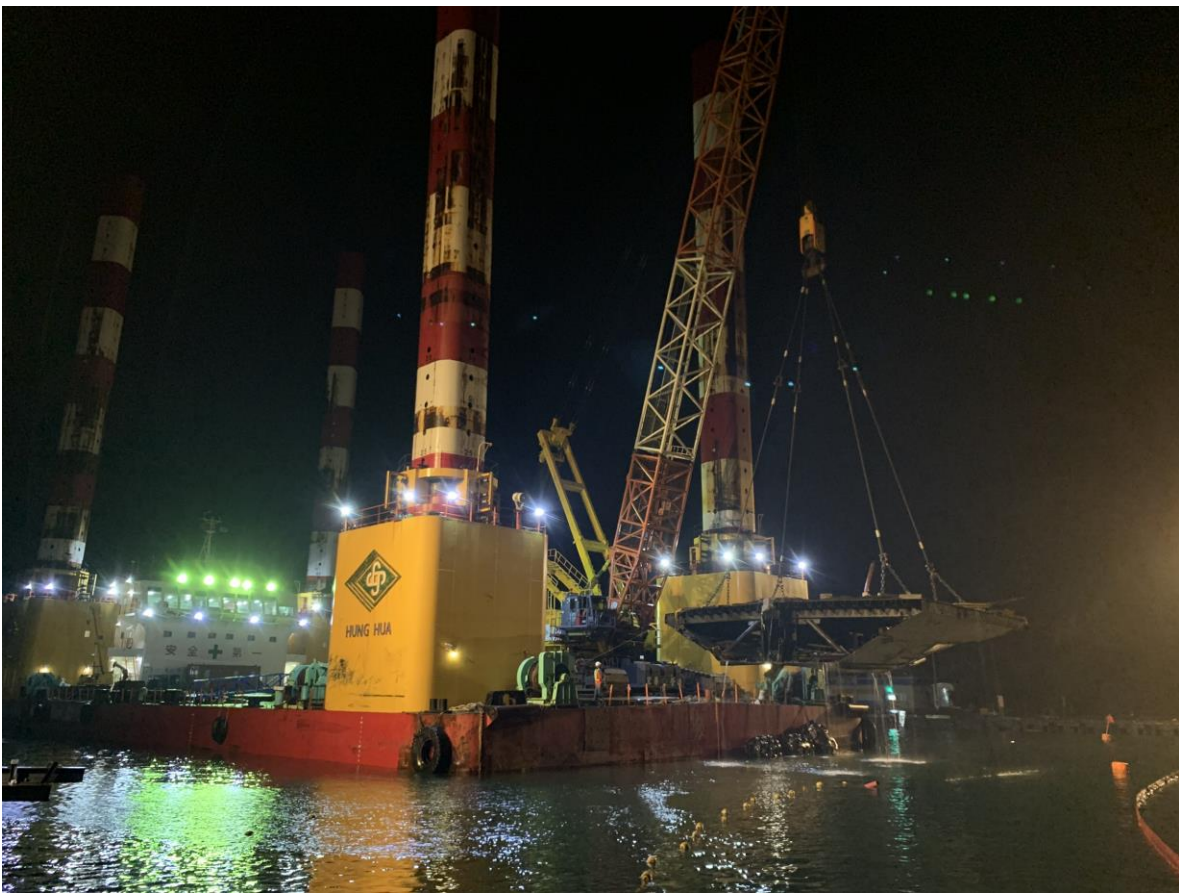
圖 3：今(4)日晚上 21：50 吊離第一塊橋面版之照片
