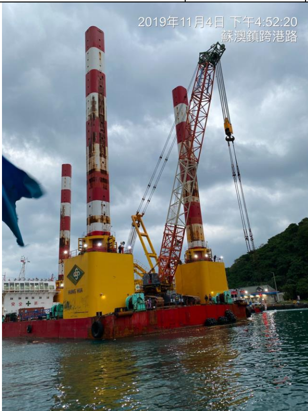
圖1：宏禹1號今（4）日再移泊至工區水域，準備吊離水下3塊橋面版
