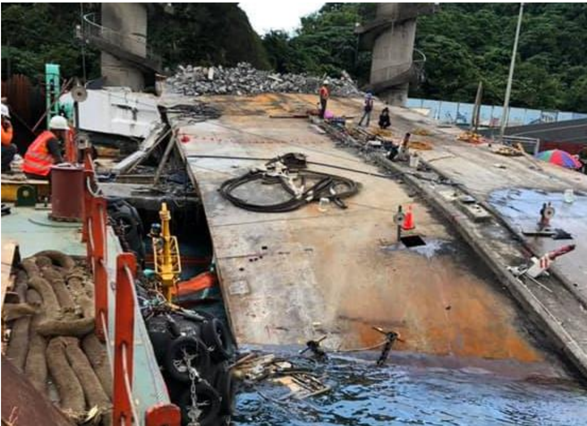
圖 1 南方澳跨港大橋拆除作業，第二條橋面版切割情況
