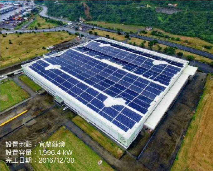
必翔電動汽車廠屋頂光電系統
