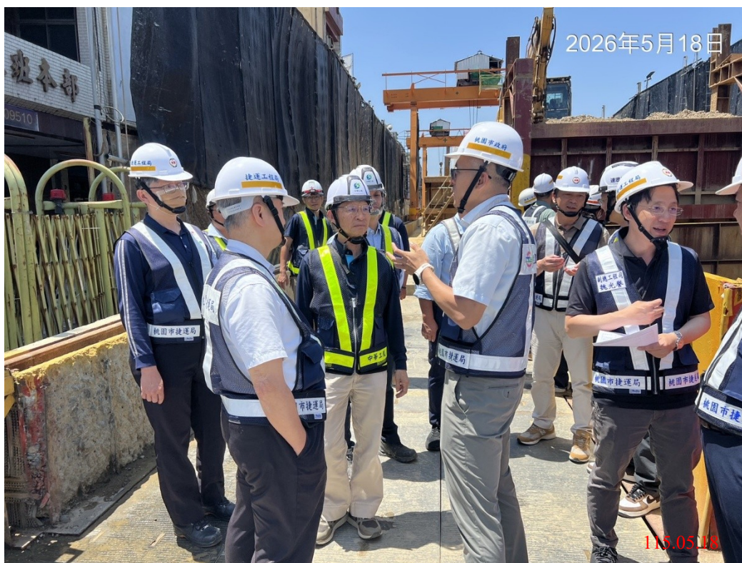
工區現況參訪及交流
