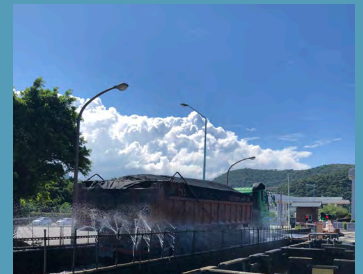
蘇澳港透過地磅與洗車台的位置結合，有效管理車輛行駛路線，減少港區內外車輛揚塵污染。
