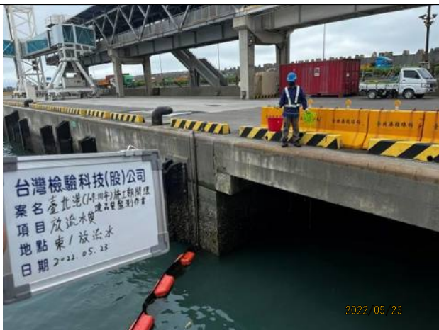
監測項目：港區放流水質 監測日期：111.5.23 監測地點：東1 放流水
