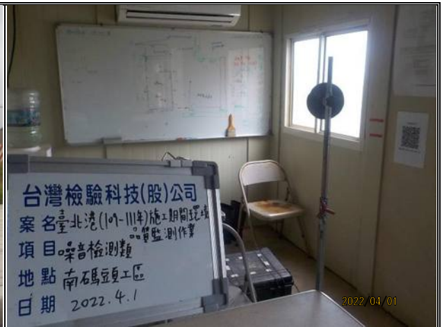
監測項目：低頻營建噪音 監測日期：111.4.1 監測地點：南碼頭工區
