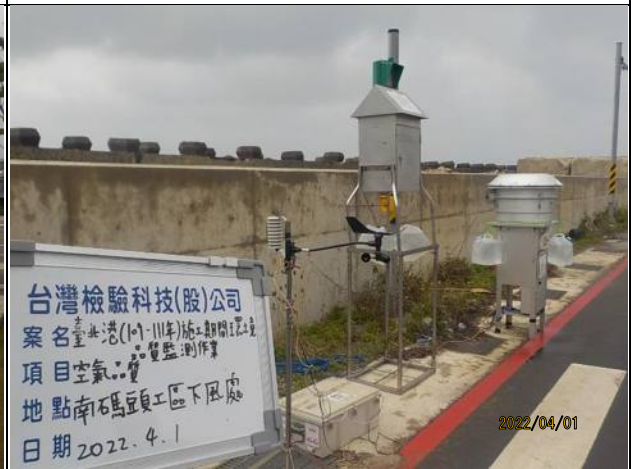
監測項目：周界空氣 監測日期：111.4.1 監測地點：南碼頭工區下風處
