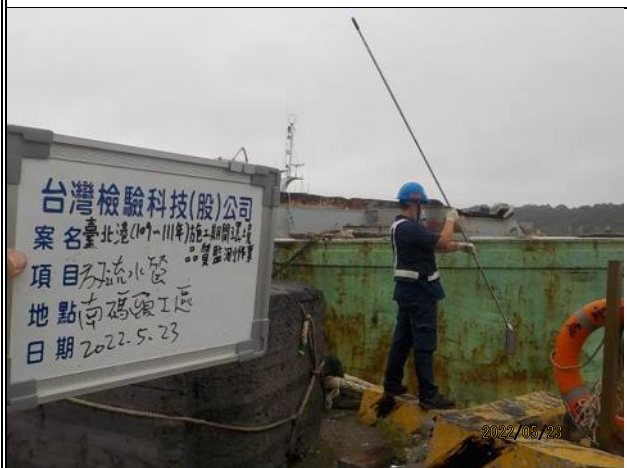
監測項目：工區放流水 監測日期：111.5.23 監測地點：南碼頭工區
