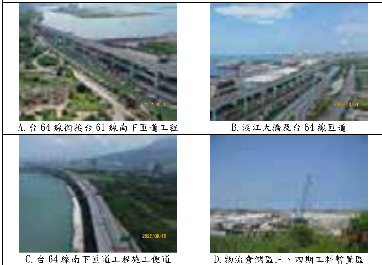
圖 1.1-3 本計畫區及附近環境現況照片(1/2)
