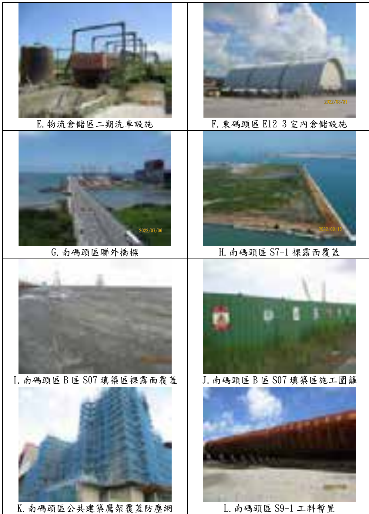
圖1.1-3 本計畫區及附近環境現況照片(2/2)
