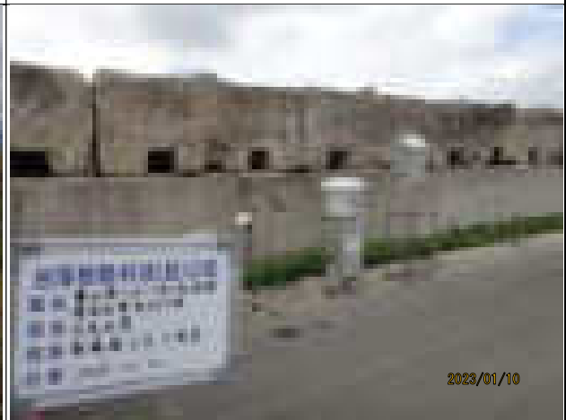
監測項目：周界空氣 監測日期：112.1.10 監測地點：南碼頭工區下風處
