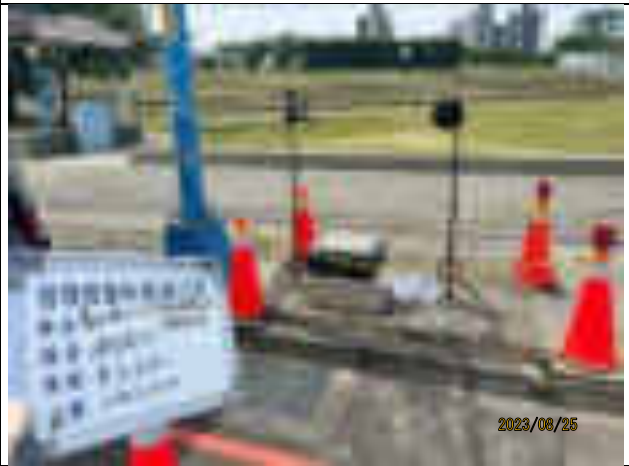
監測項目：噪音振動監測(假日&非假日) 監測日期：112.8.25~26 監測地點：東防波堤口
