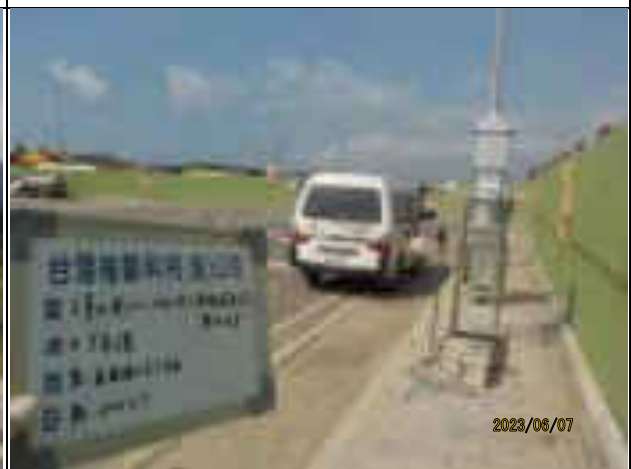
監測項目：周界空氣 監測日期：112.6.7 監測地點：南碼頭工區下風處
