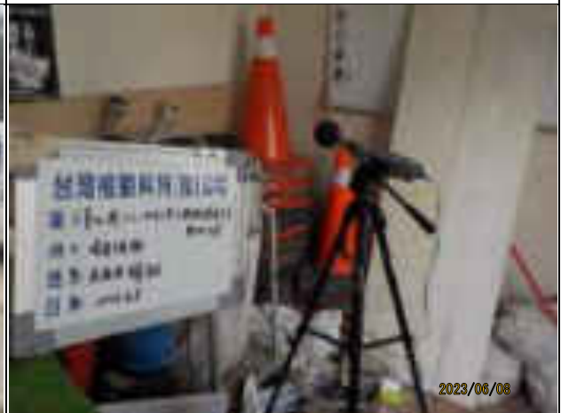
監測項目：低頻營建噪音 監測日期：112.6.8 監測地點：南碼頭自貿港區
