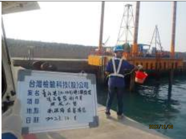
監測項目：工區放流水 監測日期：112.12.8 監測地點：南碼頭自貿港區
