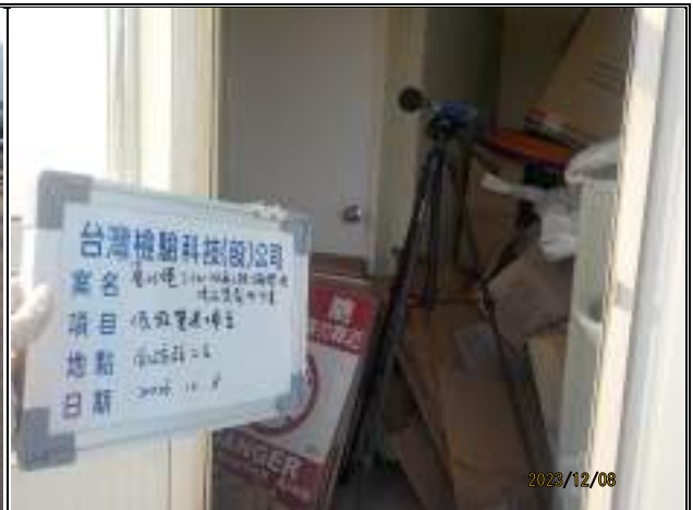
監測項目：低頻營建噪音 監測日期：112.12.8 監測地點：南碼頭工區
