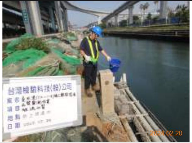
監測項目：港區放流水質 監測日期：113.2.20 監測地點：西 2 放流水
