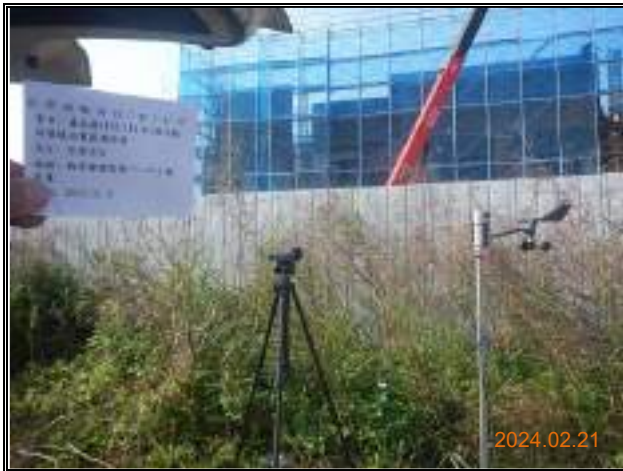
監測項目：營建噪音 監測日期：113.2.21 監測地點：物流倉儲區第一、二-1 期計畫區
