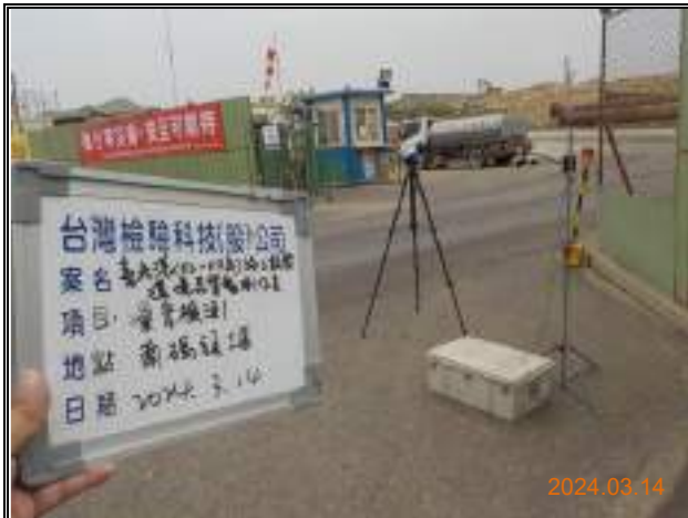
監測項目：營建噪音 監測日期：113.3.14 監測地點：南碼頭工區
