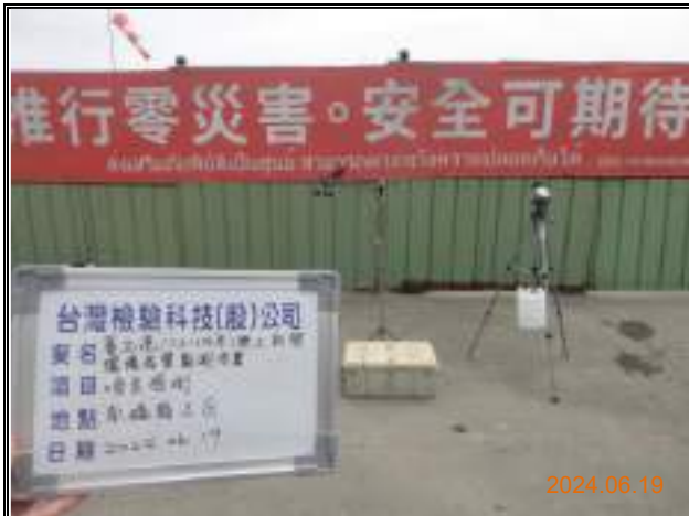
監測項目：營建噪音 監測日期：113.6.19 監測地點：南碼頭工區
