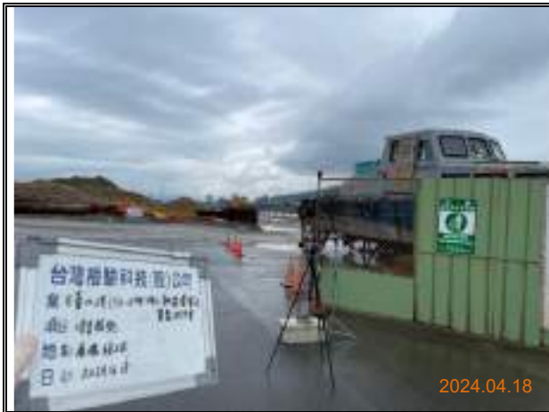
監測項目：營建噪音 監測日期：113.4.18 監測地點：南碼頭工區
