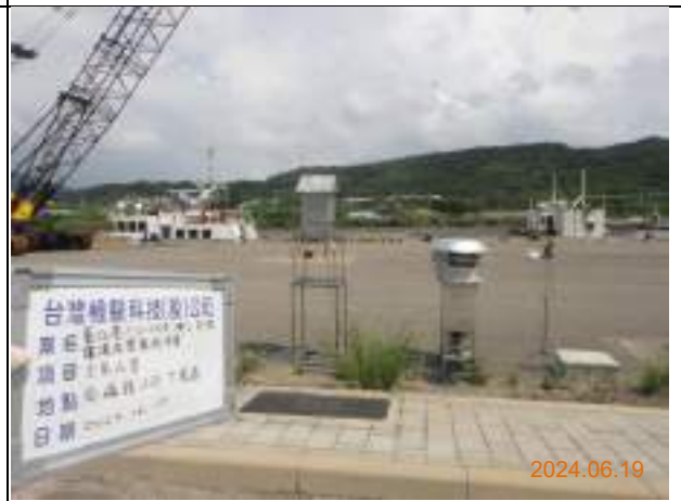
監測項目：周界空氣 監測日期：113.6.19 監測地點：南碼頭工區下風處
