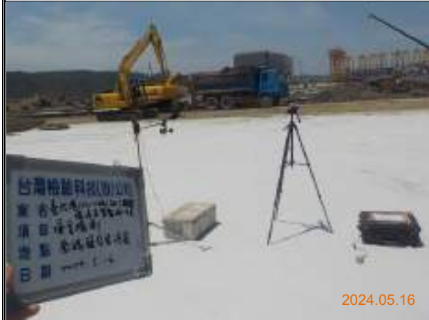
監測項目：營建噪音 監測日期：113.5.16 監測地點：南碼頭自貿港區
