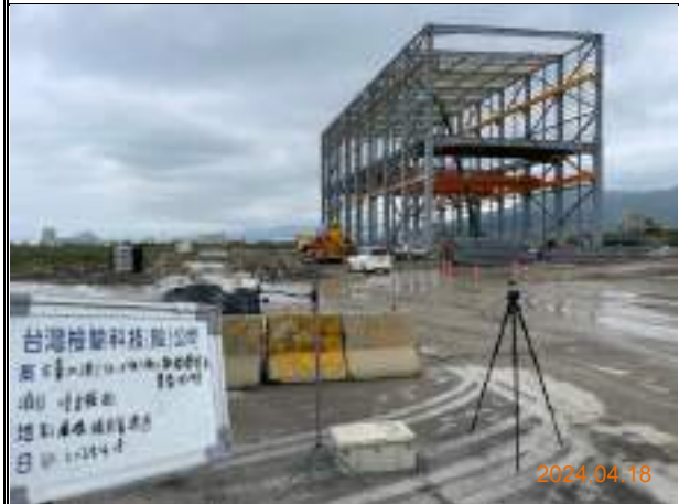
監測項目：營建噪音 監測日期：113.4.18 監測地點：南碼頭自貿港區
