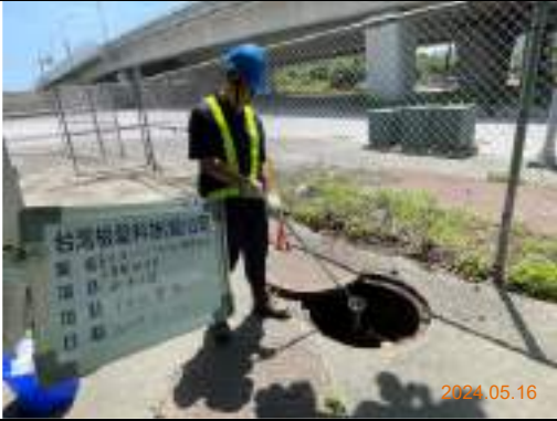
監測項目：港區放流水質 監測日期：113.5.16 監測地點：P4 加壓站
